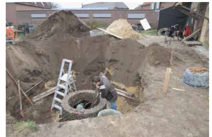
BOUW VAN DE WATERPUT OP HET ERF AAN DE BARRIERWEG 4
