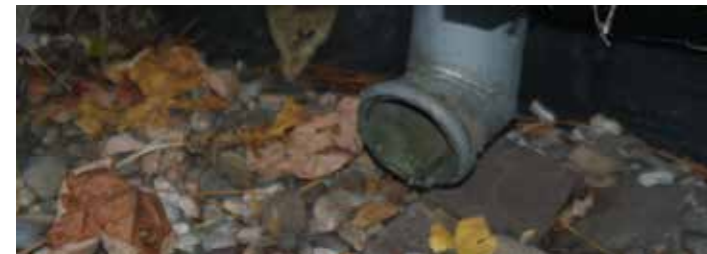
METHODE VAN AFKOPPELEN ACHTER DE WONING AAN DE OUDE DIJK 19
