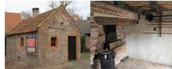
HET BAKHUIS AAN DE BARRIERWEG 23 IS IN NOVEMBER GEOPEND
